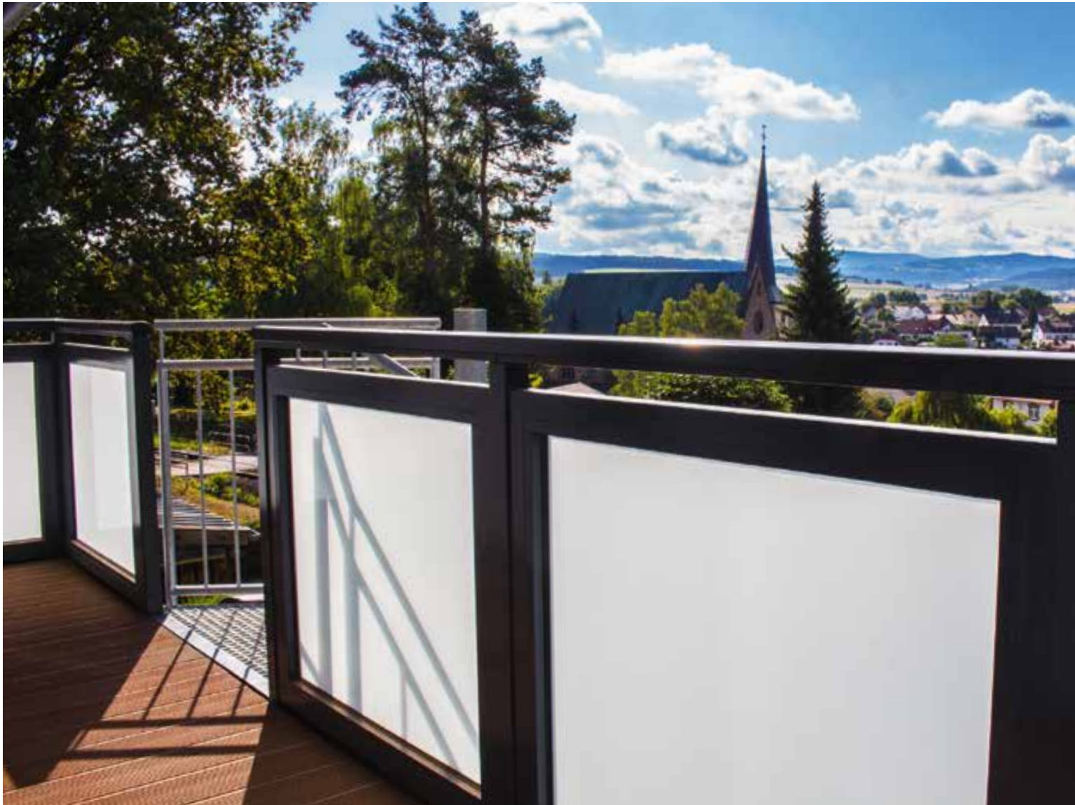
1. OG – Geländer mit Wendeltreppe. Parterre - Terrassendach in Aluminium mit Verbundsicherheitsglas (Milchglas) belegt.
