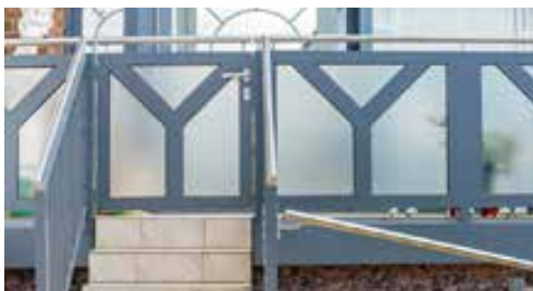
► Balkon und Geländer
