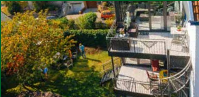
▶ Anbaubalkon, Geländer, Wintergarten zweistöckig, Spindeltreppe
