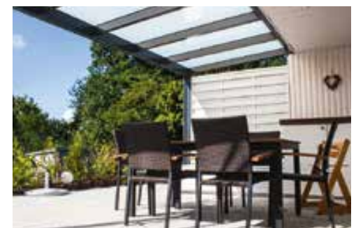
1. OG – Geländer mit Wendeltreppe. Parterre - Terrassendach in Aluminium mit Verbundsicherheitsglas (Milchglas) belegt.
